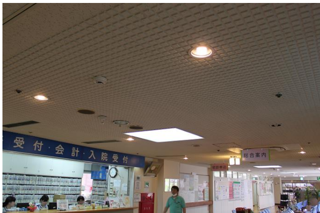
LED照明へ入替え 加治木温泉病院外来受付待合室
